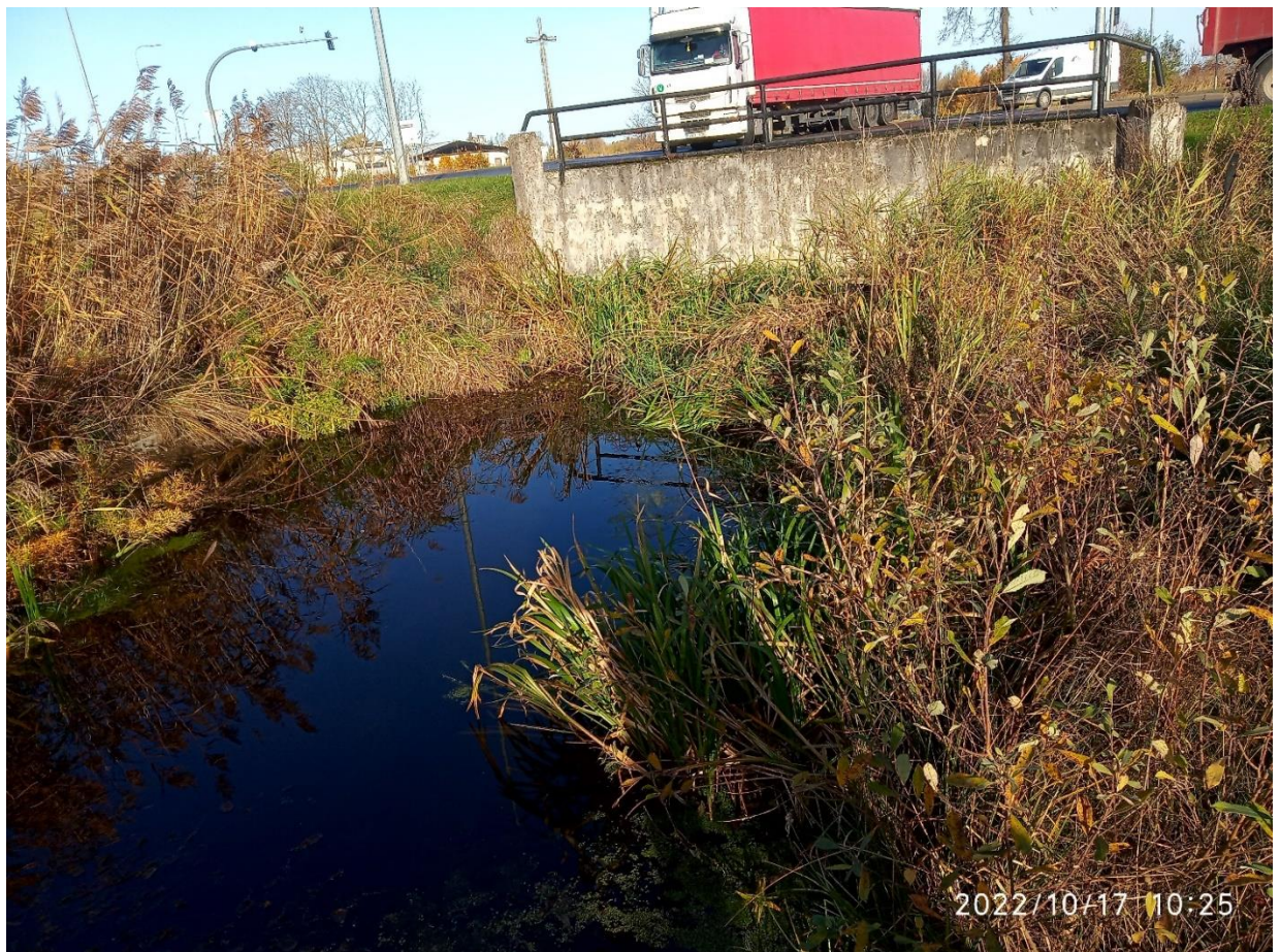
121 pav. Vandens makrofitais apaugusi Kulpės pralaida ties Tilžės g. 2022 m. rugsėjo, spalio mėn.
